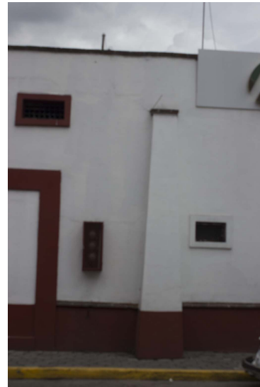
Cimiento y vista lateral.
