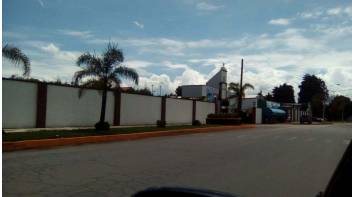
Vista lateral del inmueble.
