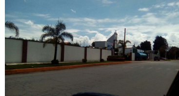
Vista lateral del inmueble.
