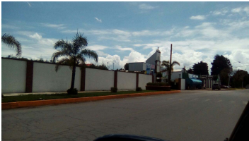
Vista lateral del inmueble.
