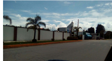
Vista lateral del inmueble.
