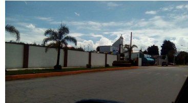
Vista lateral del inmueble.
