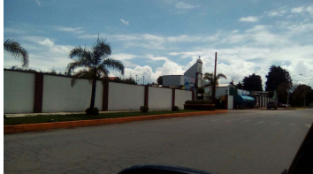
Vista lateral del inmueble.
