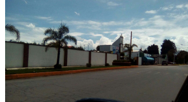
Vista lateral del inmueble.
