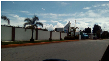
Vista lateral del inmueble.
